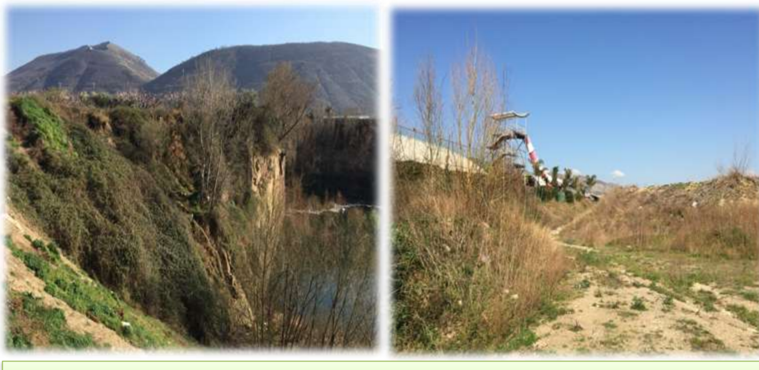
Figura 2. Stato dei luoghi - foto dell'area interessata dall'intervento
